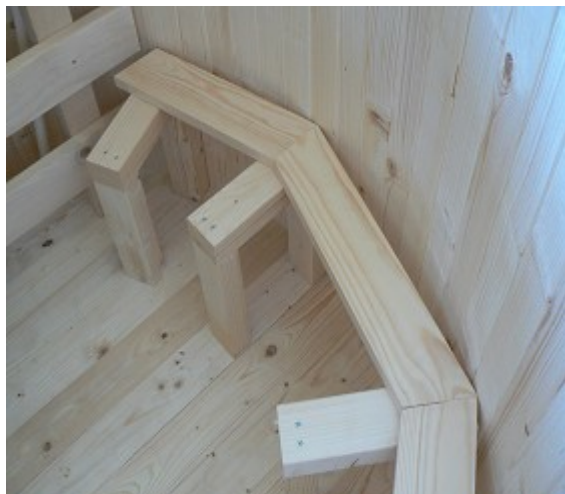
Foto 15. Istepinkide paigaldamine
