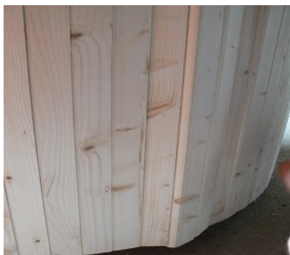
Foto 5. Viimase küljelipi paigaldamine
