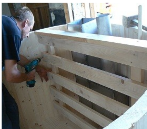
Foto 14. Vaheresti paigaldamine
