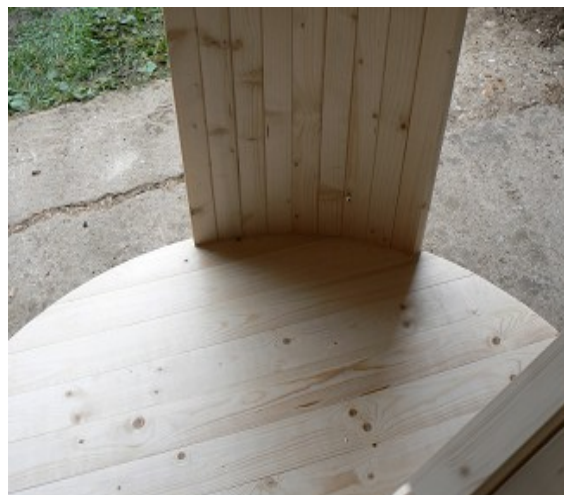
Foto 4. Paigalda lipid kellaosuti suunas
